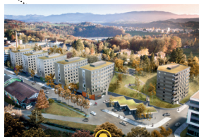
— La Fonderie (Suisse) Construction à Fribourg sur 16 000 m 2 de 143 logements étudiants en colocation et 28 appartements locatifs.
