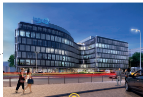
— Infinity (Pologne) Construction à Wrocław d'un immeuble de bureaux BREEAM Excellent de 22 000 m 2 .
