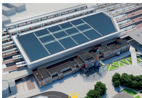
— Gare de Gand-Saint-Pierre (Belgique) Transformation de la gare, aménagement partiel du RDC et du niveau -1 et renouvellement des voies et des quais.
